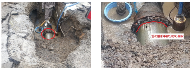
※450mm配水管の漏水箇所（別府市古市5組 西念寺前市道）
