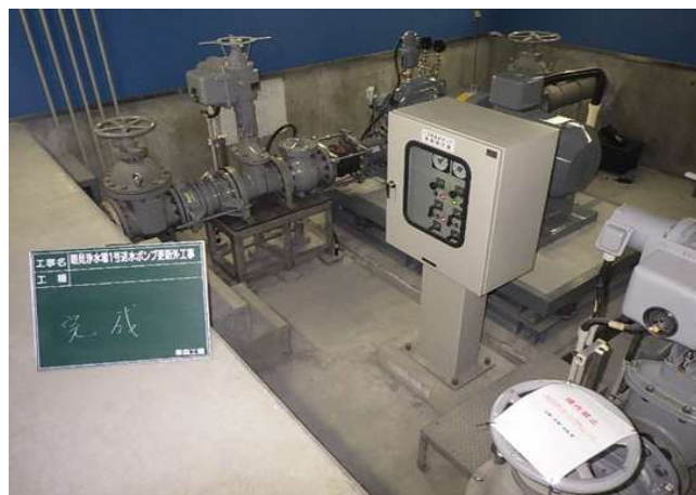
朝見浄水場1号送水ポンプ更新外工事
