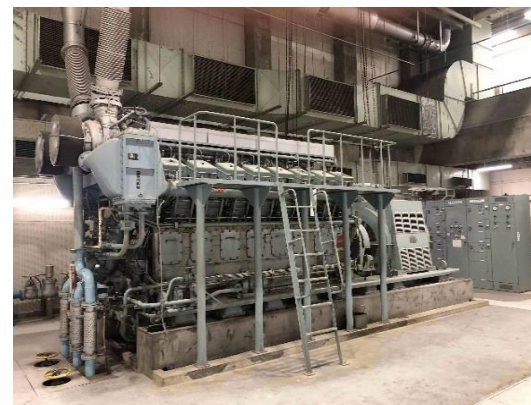
別府市公共下水道処理場及び ポンプ場工事委託に関する協定 (予算繰越分)
