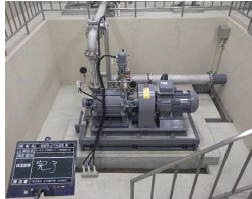
影ノ木ポンプ場電気・ポンプ設備更新工事
