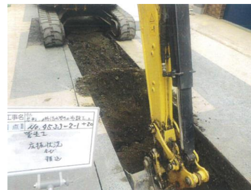
元町7番外 污水管きよ布設工事
