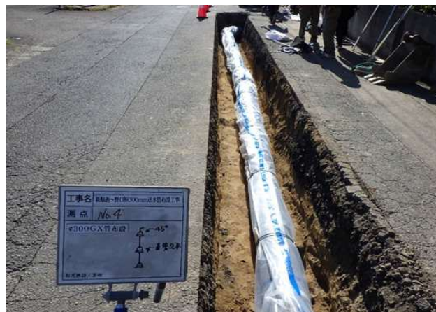
新鮎返～野口原 300mm送水管布設工事
