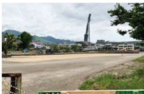
旧山の手中学校跡地 校舎や体育館等が解体されている 約380台の仮設駐車場に整備される
