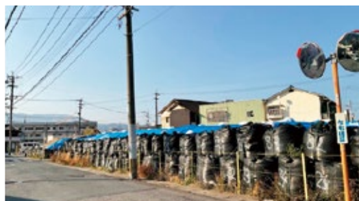
浜脇秋葉線整備事業 浜脇側の資材置き場 橋梁工事等に使用される巨大な大量の土嚢
