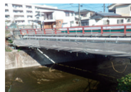
▲ 霊泉寺橋 300mm送水管布設替工事
