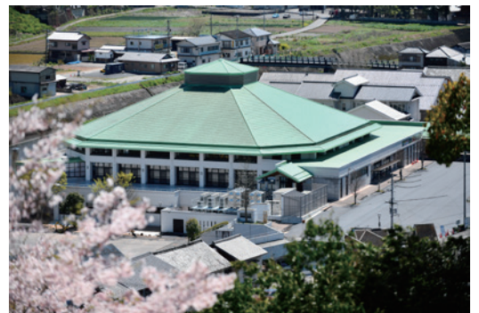
復旧した乙亥会館
