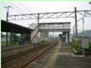
亀川駅にエレベーターを設置して！
