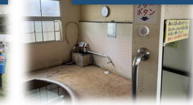
緊急ブザー設置
