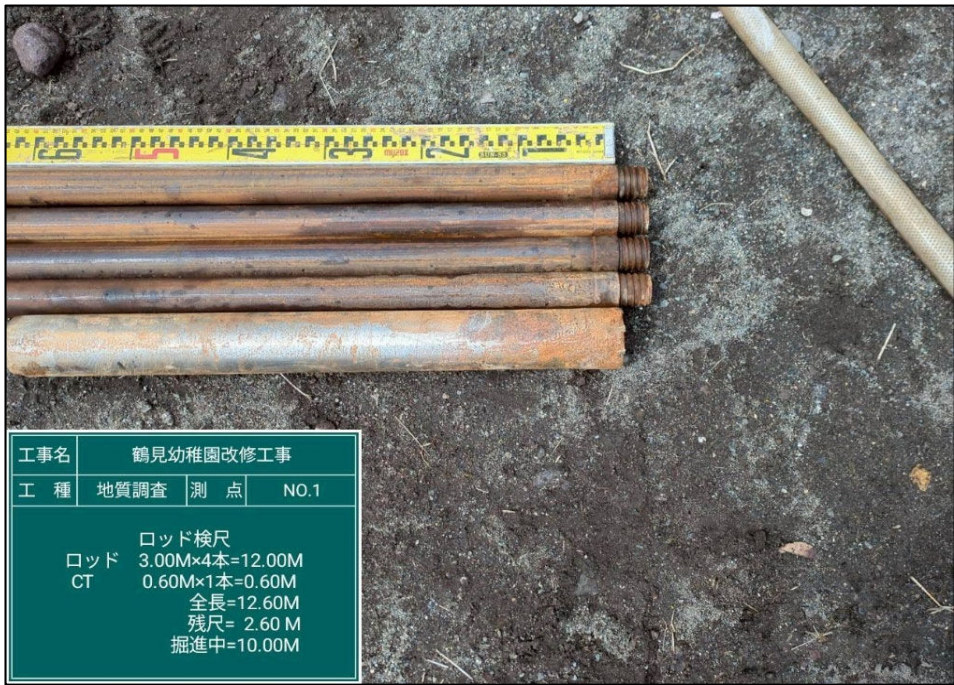
ロッド検尺 掘進長10.0m
