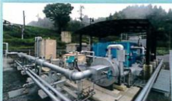
● 低濃度の媒体を利用して発電する『バイナリー発電』
