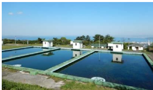
■ 扇山浄水場 緩速ろ過池 ■
