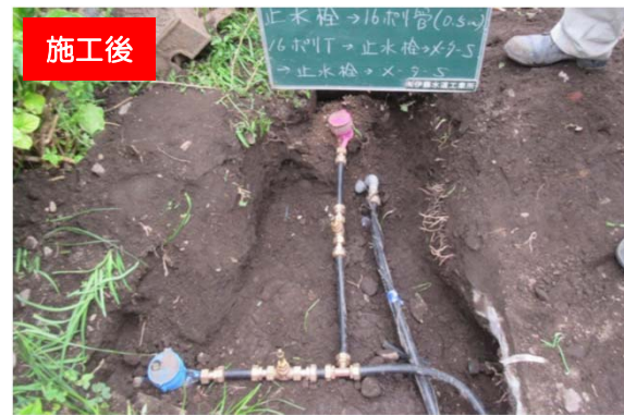
■ 鉛管取替工事 ■
