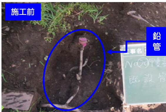
■ 鉛管取替工事 ■
