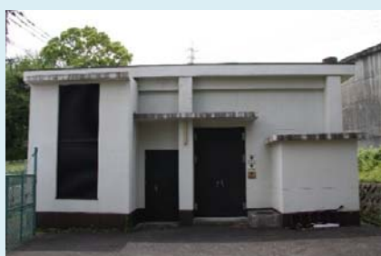
荘園ポンプ場
