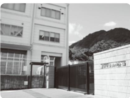
《民間委託が決定した朝見浄水場》
