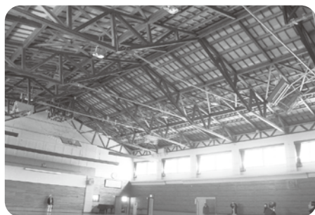
《屋根改修工事を行う東山小中学校体育館》
