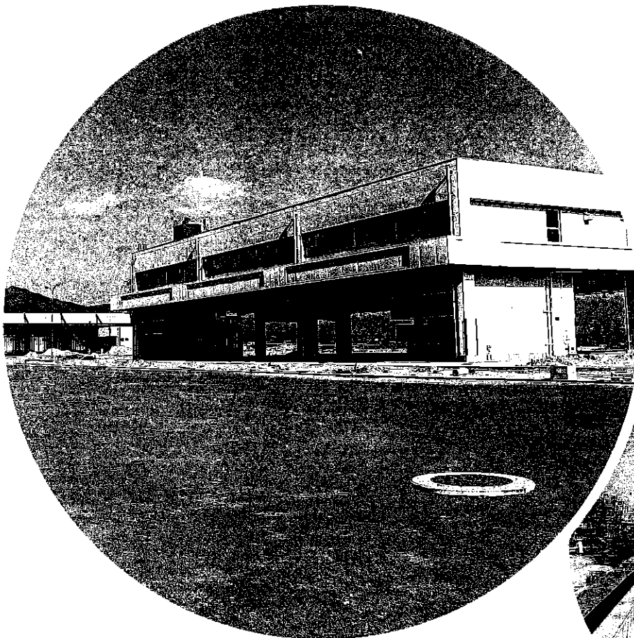
完成した公設地方卸売市場
