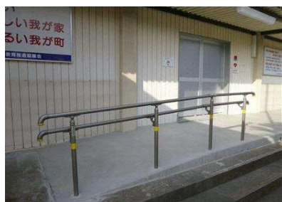
スロープの設置
