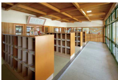
昇降口の段差を解消
