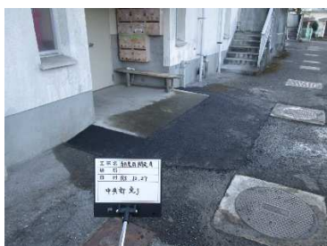
階段室入口の段差解消
