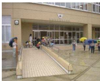
スロープの設置
