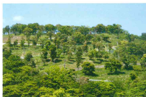
植生により擁壁などを覆いかくします。
