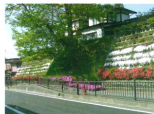
緑化ブロックの施工例
