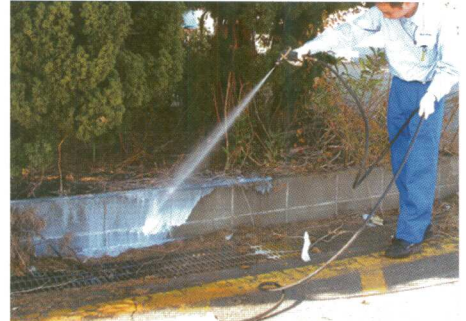
専門業者による液剤の高圧散布
