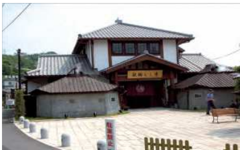
鉄輪むし湯 かつての建物は、十六羅漢を模して八角形の構造で一度に16人が収容できたとされる 3)
