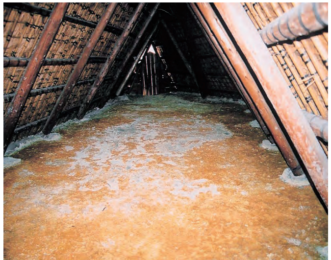
写真7.3.3 現在の湯の花小屋内部
