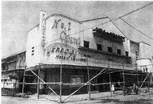
キャバレーNo.1 解体工事前
