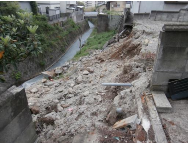
写真 塀・基礎などの被害
