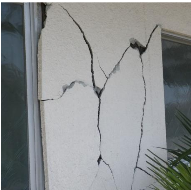
写真 塀・基礎などの被害
