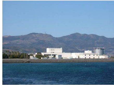
■中央浄化センター
