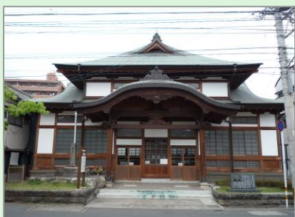
▲文化財の亀川浜田温泉資料館
