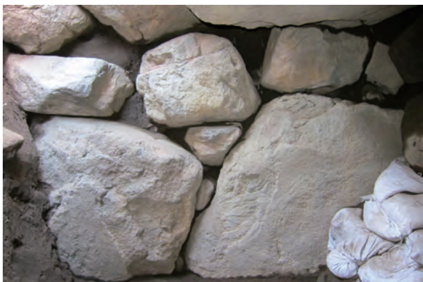
鷹塚古墳3 トレンチ羨道内左側壁石積状況
